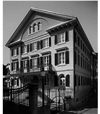
Stiftungshaus in Zürich
